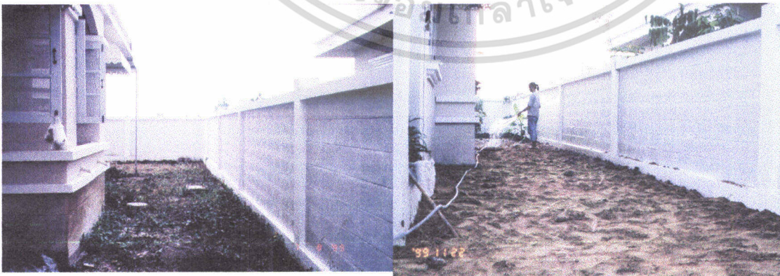
ภาพที่ 8 แสดงพื้นที่จัดสวนด้านซ้ายของบ้านก่อนและระหว่างการปฏิบัติงาน
