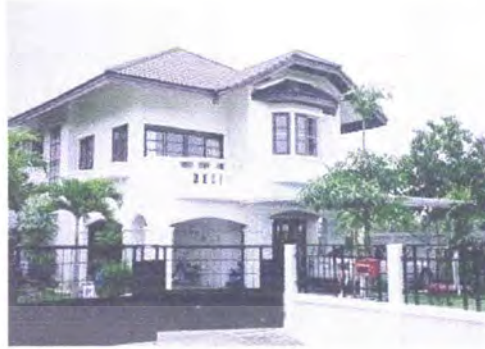
ภาพที่ 8 แสดงตัวบ้านที่ทำการปรับปรุงสภาพภูมิทัศน์
