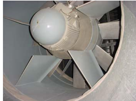
รูปที่ 5.10 มอเตอร์สำหรับระบายอากาศในอุโมงค์ของระบบรถไฟใต้ดิน
