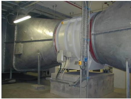
รูปที่ 5.10 มอเตอร์สำหรับระบายอากาศในอุโมงค์ของระบบรถไฟใต้ดิน
