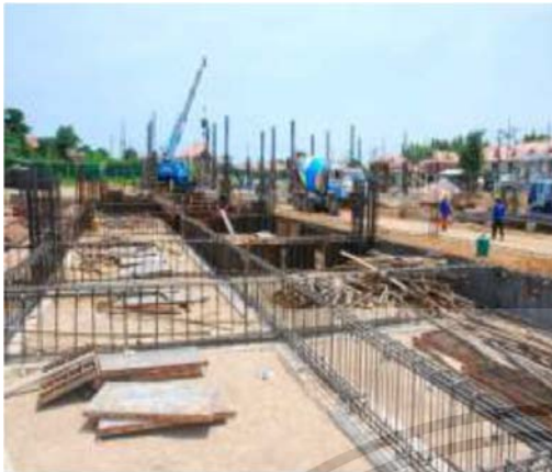
รูปที่ 2.84 การตีแบบห้องคานด้วยไม้
