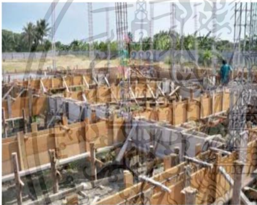
รูปที่ 2.86 การเข้าแบบข้างคานด้วยแบบไม้
