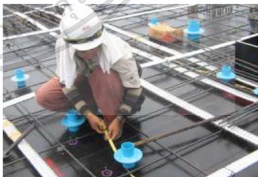
รูปที่ 2.119 การวางสลีปและช่องเปิดต่างๆ
