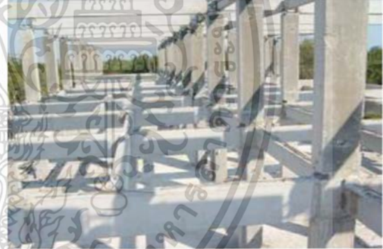
รูปที่ 2.95 เสาและคานสำเร็จรูป
