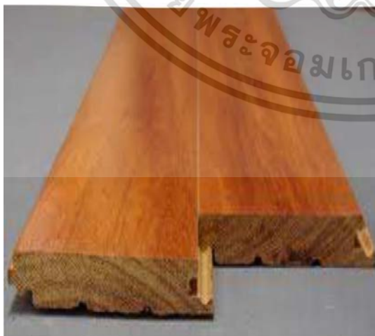
รูปที่ 2.11 พื้นไม้แบบบังใบ
