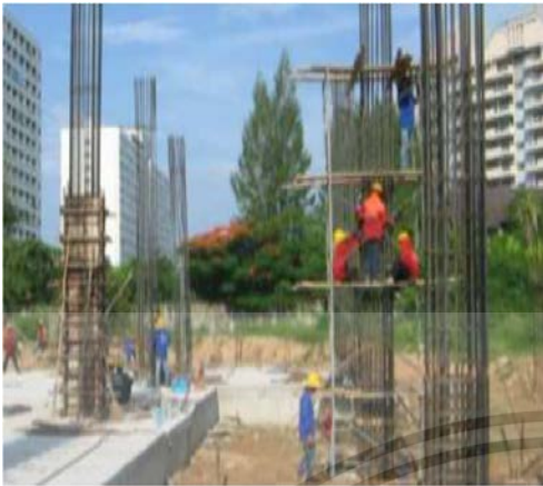
รูปที่ 2.78 การผูกเหล็กปลอกเสาคอนกรีต
