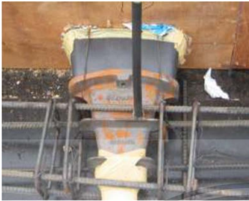
รูปที่ 2.120 การวางหัว Anchorages
