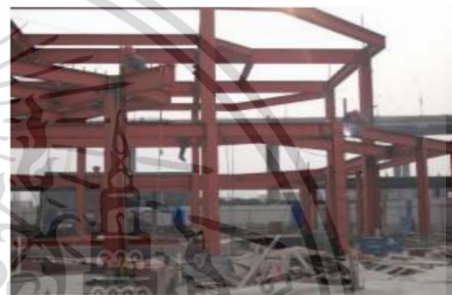
รูปที่ 2.27 แบบโครงเหล็กรูปพรรณ เสา คาน โครงหลังคา
