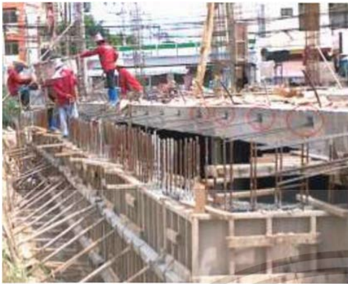
รูปที่ 2.124 แสดงการวางสลิงให้ยาวออกมา รูปที่จากพื้น เพื่อทำการตั้งสลิง
