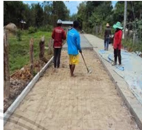
รูปที่ 2.54 การเทคอนกรีตพื้นประเภทฝาก น้ำหนักบนพื้นดิน (Slab on ground)
