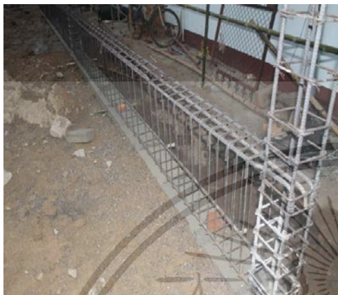
รูปที่ 2.48 ภาพเหล็กเสริมของเสา คสล.
