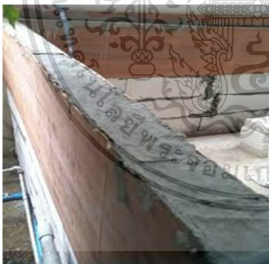
รูปที่ ข.17 เทคานทับหลัง
