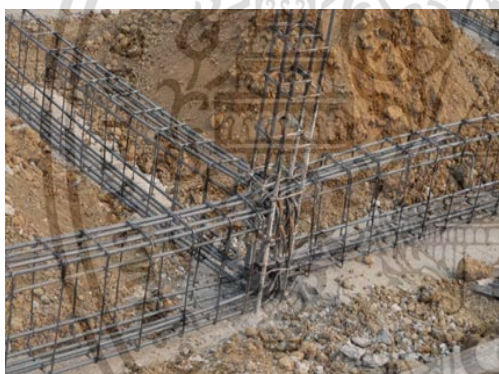
รูปที่ ข.7 ผูกเหล็กเสริมแกน และเหล็กปลอกคาน
