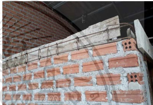
รูปที่ ข.16 เข้าแบบคานเอน
