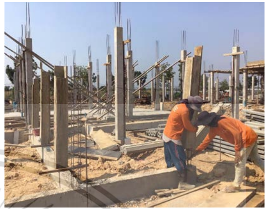
รูปที่ ข.2 ทำแบบหล่อ
