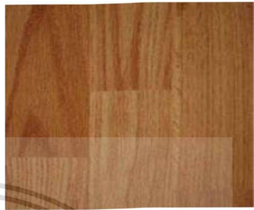
รูปที่ 2.14 พื้นไม้ที่อัดสนิทต้องการแต่งโดยใช้กบผิวใสหรือกระดาษทรายขัดบริเวณรอยต่อให้เสมอกัน
