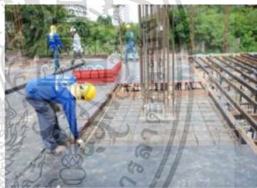
รูปที่ 2.117 การผูกเหล็กเสริม R.C. ในพื้น โพสเทนชั้น
