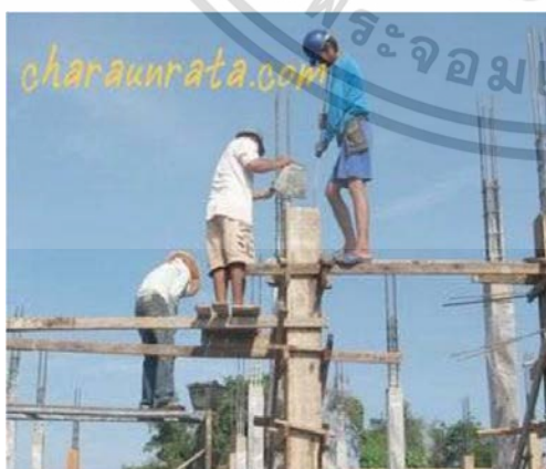
รูปที่ 2.82 การเข้าแบบเสาด้วยแบบไม้เหล็ก
