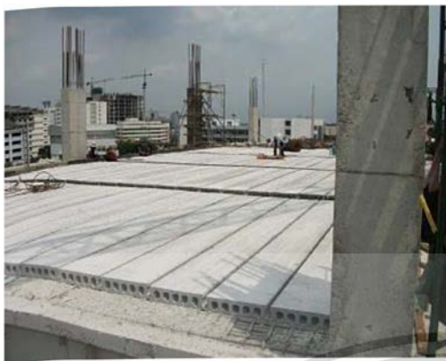
รูปที่ 2.106 พื้นสำเร็จรูปแบบกลวง (HollowCore)
