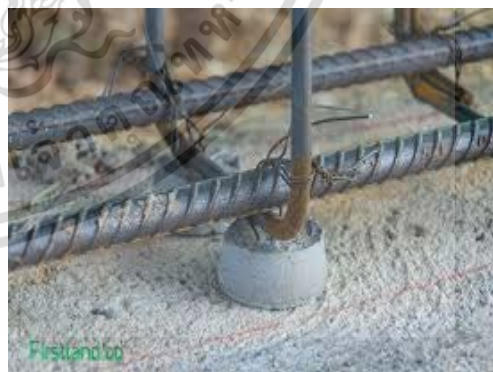
รูปที่ 2.57 การหุนลูกปูนก่อนเทคอนกรีต ให้ได้ระยะ Covering ถูกต้องตามแบบ
