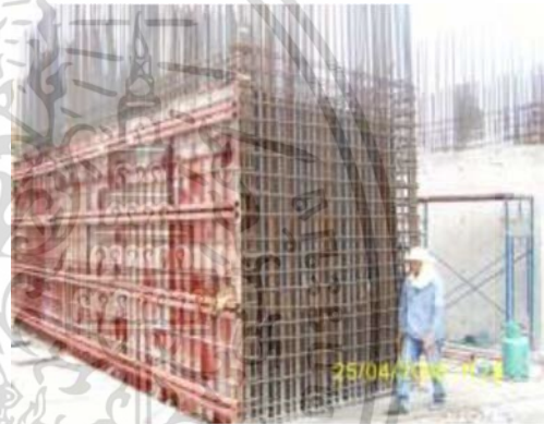
รูปที่ 2.81 การผูกเหล็กผนังลิฟต์
