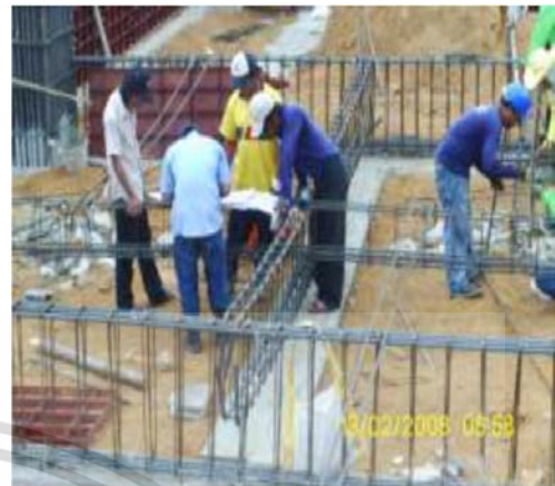
รูปที่ 2.79 การผูกเหล็กคานคอนกรีต
