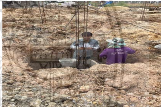
รูปที่ ข.4 ทหารระดับเทคอนกรีต
