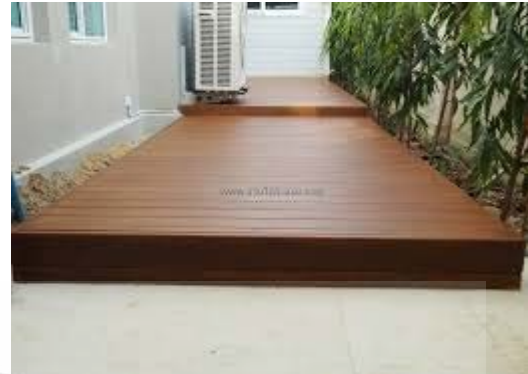
รูปที่ 2.18 การปูไม้พื้นจริงภายนอกอาคาร
