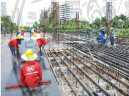
รูปที่ 2.116 การปูไม้แบบบนตงเพื่อเป็นแบบ รองท้องพื้นโพสเทนชั้น
