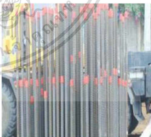
รูปที่ 2.73 การเตรียมต่อเหล็กเสาคอนกรีตโดยใช้ Coupler
