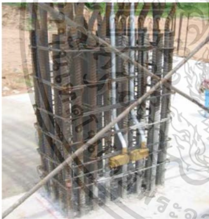
รูปที่ 2.76 การเตรียมต่อเหล็กเสาโดยวิธีการทาบเหล็ก
