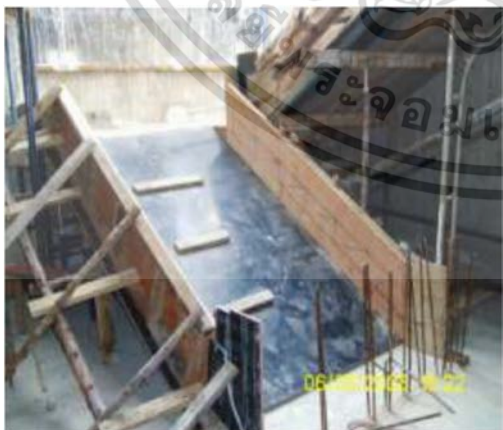
รูปที่ 2.88 การเข้าแบบห้องบันได คสล.
