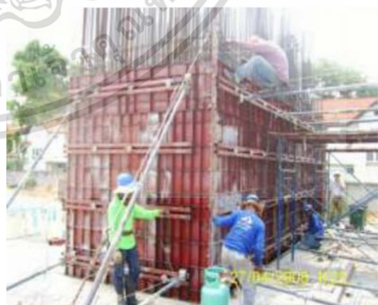
รูปที่ 2.89 การเข้าแบบข้างผนังลิฟต์
