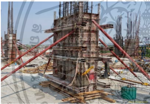
รูปที่ ข.3 ติดตั้งค้ำยันแบบหล่อเสา
