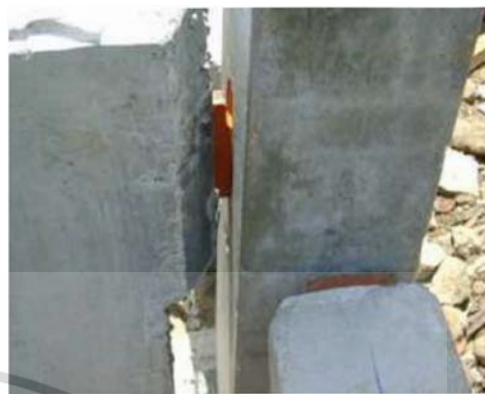
รูปที่ 2.113 ตรวจสอบรอยเชื่อมให้ได้ขนาดและมีการทาสีกันสนิม ไม่ว่าจะด้วยระบบใด
