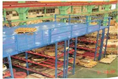
รูปที่ 2.39 พื้นเหล็กตะแกรง ในโรงงาน อุตสาหกรรม
