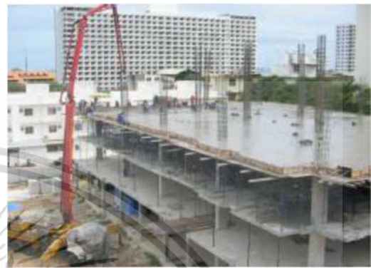
รูปที่ 2.61 การเทคอนกรีตพื้นด้วยระบบปั๊มส่งคอนกรีต (PUMPING CONCRETE) ซึ่งสามารถส่งคอนกรีตไปยังที่เทได้อย่างรวดเร็ว ลดการเสื่อมคุณภาพการก่อตัวของปูนซีเมนต์
