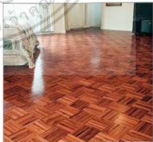
รูปที่ 2.12 พื้นไม้ปาร์เก้ภายในอาคาร
