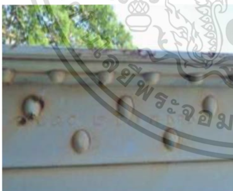
รูปที่ 2.46 หมุดย้ำในการเชื่อมต่อโครงสร้างเหล็ก ต้องอัดแน่นและทำให้แผ่นเหล็กแนบติดกันสนิทมีใช้น้อยมากในยุคนี้
