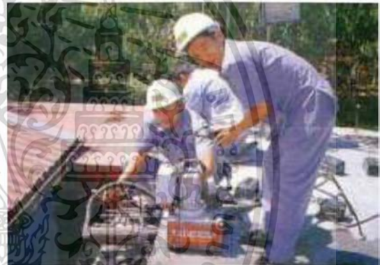
รูปที่ 2.127 ทำการตั้งสลิงด้วยเครื่อง ไฮดรอลิกส์ให้ได้กำลังตามที่กำหนด
