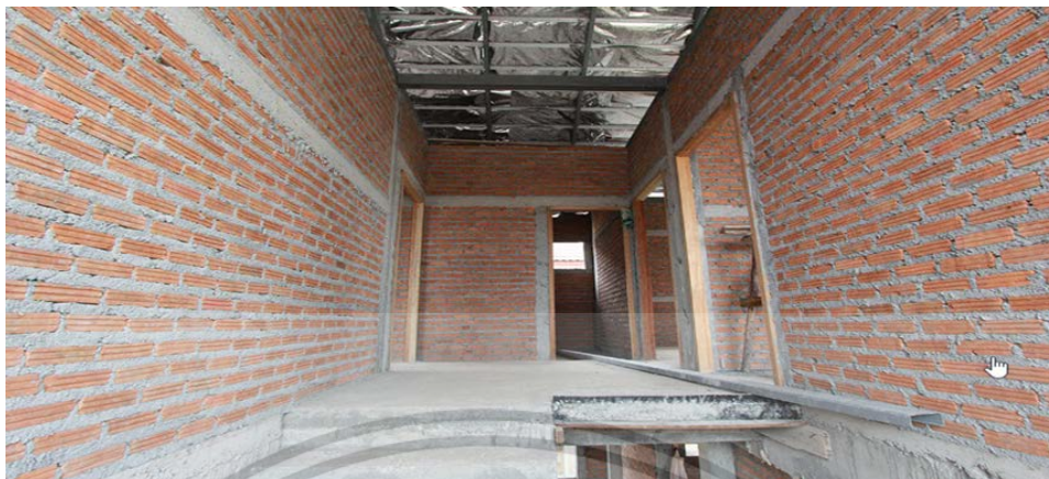
รูปที่ ข.21 ผนังห้องที่ก่ออิฐแล้วเสร็จ
