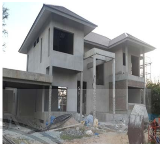
รูปที่ ข.25 งานฉาบปูนภายนอกแล้วเสร็จ
