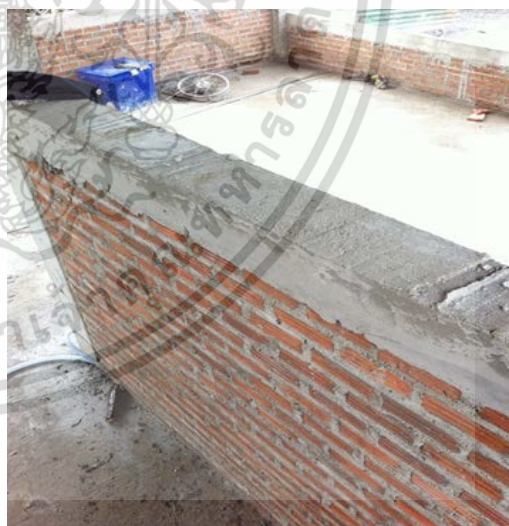
รูปที่ ข.18 ถอดแบบคานทับหลังออก
