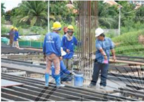
รูปที่ 2.114 การตั้งทั้งร้านเหล็กเป็นค้ำยัน ท้องแบบหล่อพื้นโพสเทนชั้น
