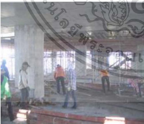
รูปที่ 2.92 การรื้อแบบห้องพื้น
