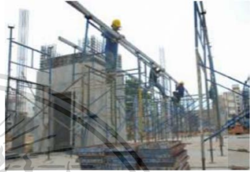
รูปที่ 2.115 การวางตงเพื่อรองรับแบบหล่อ พื้นโพสเทนชั้น
