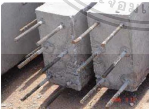
รูปที่ 2.96 เหล็กจากคานสำเร็จรูปเป็นตัวยึดกับเสาหรือคานตัวอื่น สำหรับสอดเข้าไปใน
