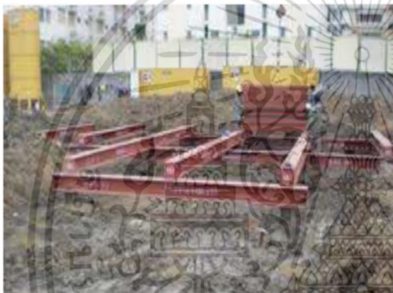
รูปที่ 2.30 การวางคานเหล็กรูปพรรณ ที่ใกล้ความขึ้นต้องทาสีกันสนิม
