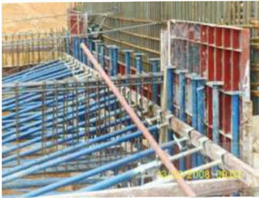
รูปที่ 2.90 แสดงการใช้นั่งร้านเป็นเสารับกำลังห้องแบบพื้นหรือคานในแนวตั้ง
