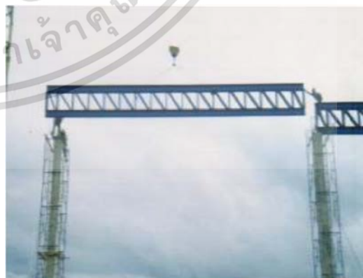
รูปที่ 2.33 การติดตั้งคานประกอบโดยการใช้เครน
