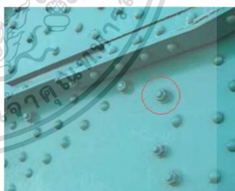
รูปที่ 2.47 การยึดน็อตในโครงสร้างเหล็ก ต้องขันให้แน่นและแนบติดกันสนิท
