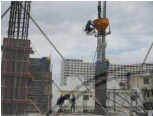
รูปที่ 2.60 การเทคอนกรีตเสาโดยใช้บั๊กเก็ต (BUCKETS) และมีกรวยรับคอนกรีตพร้อมท่อผ้าใบลงคอนกรีตไปยังแบบหล่อเสาเพื่อลดการกระแทกของคอนกรีตกับเหล็กเสริม
