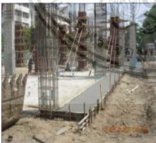
รูปที่ 2.72 การวางเหล็กเสาคอนกรีต
