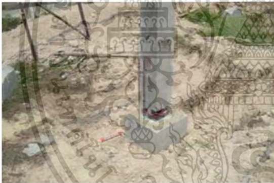
รูปที่ 2.94 จุดต่อระหว่างเสาและฐานรากสำเร็จรูป
