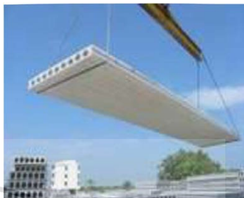
รูปที่ 2.107 การยกพื้นสำเร็จรูปแบบกลวง เพื่อติดตั้ง
