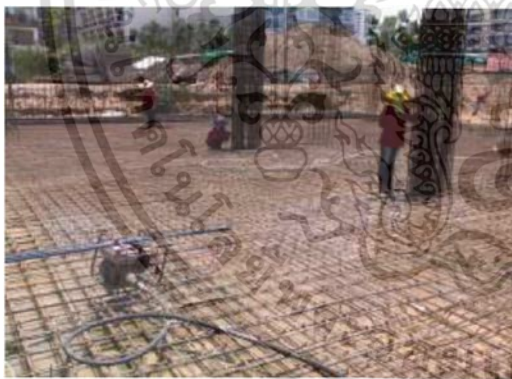
รูปที่ 2.62 สำหรับงานเทคอนกรีตในงานขนาดใหญ่ต้องมีเครื่องเขย่าปูน (VIBRATORS) เพื่อไล่ฟองอากาศทำให้คอนกรีตแน่นตัว
