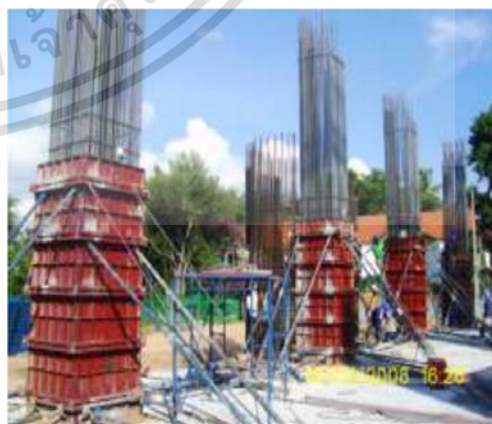
รูปที่ 2.83 การเข้าแบบเสาด้วยแบบเหล็ก
