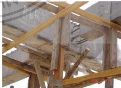
รูปที่ 2.97 การเชื่อมต่อคานสำเร็จรูปที่เป็นคานหลักกับคานซอยกับคานสำเร็จรูปที่เป็นคานหลัก
