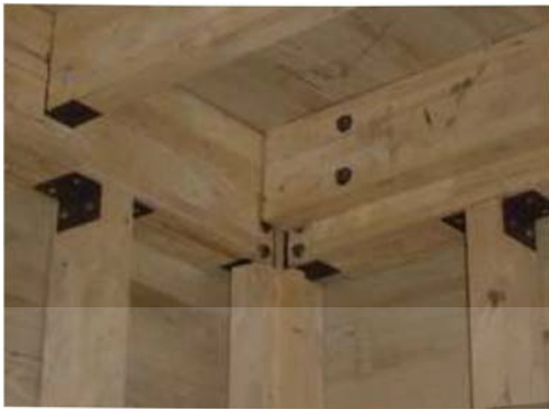
รูปที่ 2.17 แสดงโครงสร้าง เสา คาน ตงไม้
