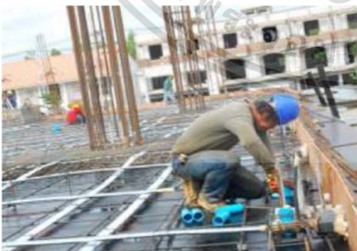
รูปที่ 2.118 การวางสลิงรับกำลังของพื้นโพส
