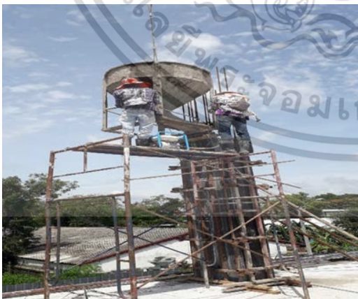
รูปที่ ข.5 เทคอนกรีต
