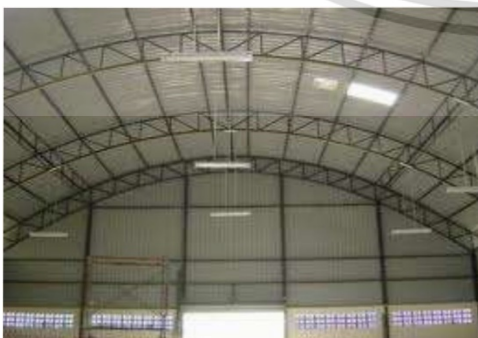
รูปที่ 2.42 โครงหลังคาเหล็ก (Truss) ทรงโค้ง
