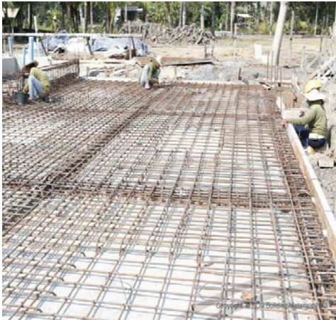
รูปที่ 2.53 การเทคอนกรีตพื้นประเภทฝาก น้ำหนักบนคาน (Slab on beam)
