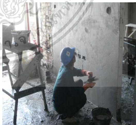
รูปที่ ข.23 งานฉาบปูนภายใน
