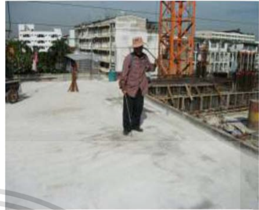
2.125 การบ่มคอนกรีตด้วยน้ำยาบ่ม คอนกรีต
