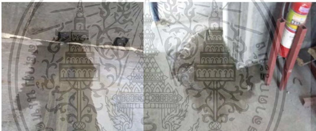
รูปที่ 4.2.4 น้ำปูน จากการอัดน้ำปูนอุดช่องว่างในท่อหุ้มลวด POST-TENSIONED
