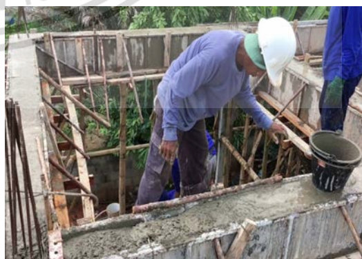
รูปที่ ข.10 งานเทคานคอนกรีต
