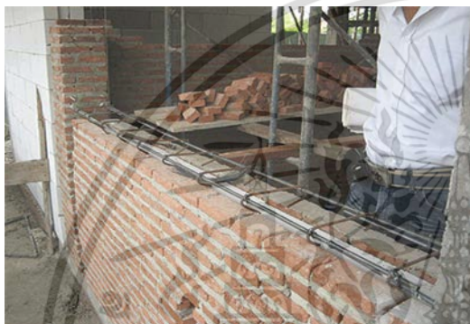
รูปที่ ข.15 การสอดเหล็ก
