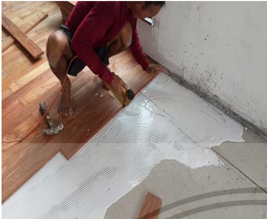
รูปที่ 2.13 การปูพื้นไม้ต้องอัดให้สนิท
