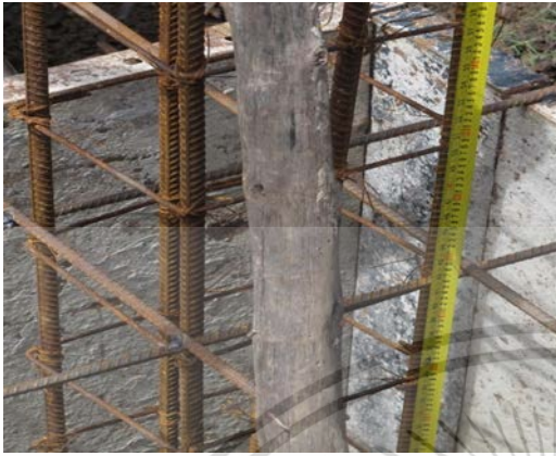
รูปที่ ข.1 ผูกเหล็กเสริมแกนเสา และเหล็กปลอก
