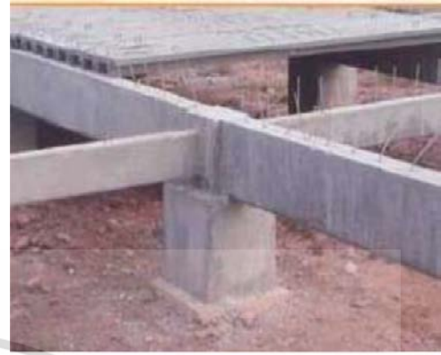
รูปที่ 2.99 หลังจากเชื่อมรอยต่อแล้วต้องตกแต่งให้เรียบร้อย
