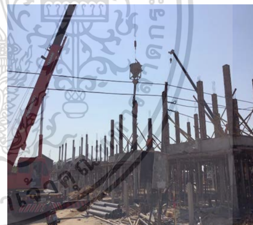
รูปที่ ข.14 การเทคอนกรีตชั้น 2
