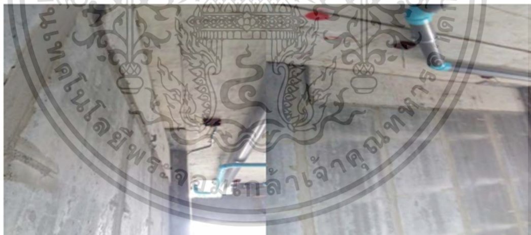
รูปที่ 4.2.3 ตัวอย่างคาน คสล. ล้นเข้ามาในห้อง
