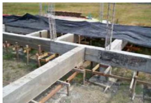
รูปที่ 2.51 การเว้นช่องสำหรับสอดเหล็กพื้นรูปที่ 2.52 การแกะแบบข้างคานและตรวจดูว่ามีโพรงในคอนกรีตหรือไม่ ส่วนแบบท้องคานต้องให้คอนกรีตได้อายุตามที่กำหนดจึงสามารถแกะแบบได้
