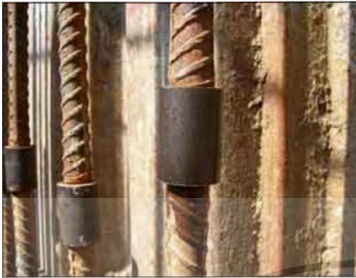
รูปที่ 2.74 การต่อเหล็กเสาโดยวิธี Coupler
