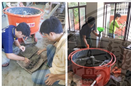
รูปที่ 3.15 กรอกคอนกรีตมวลเบาแบบเซลลูล่า
