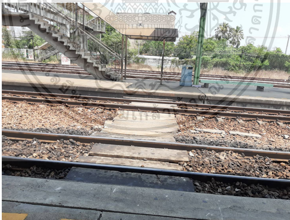
ภาพที่ 4.19 ทางข้ามรางรถไฟสถานีรถไฟหัวตะเข้
