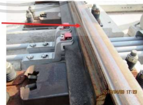
รูปที่ 2.14 ระยะระหว่างลิ้นรางและรางประกอกลิ้นตำแหน่งปิด
