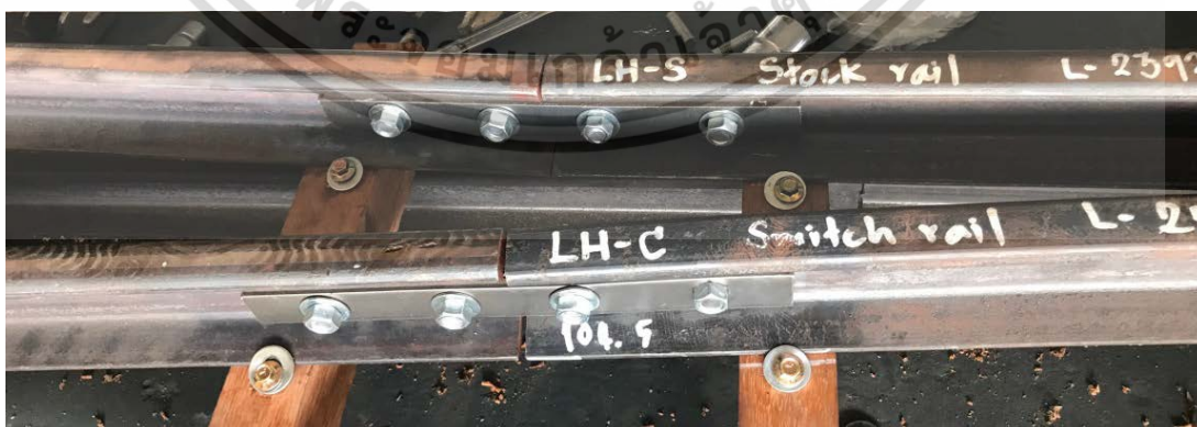
รูปที่ 3.32 การเชื่อมรางแบบรางต่อ
