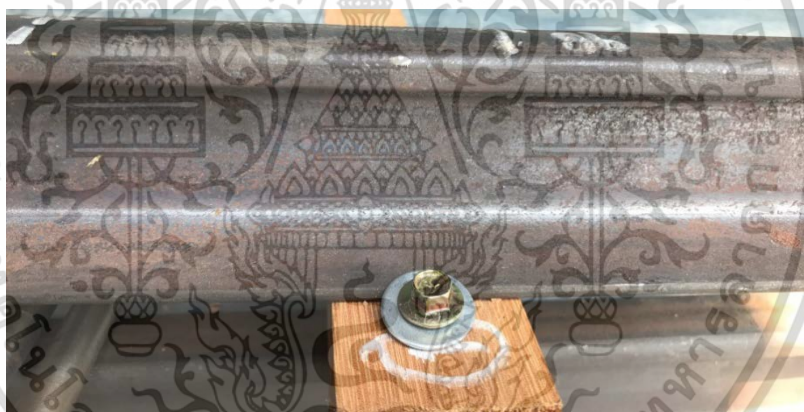
รูปที่ 3.29 การยึดเหล็กรางรถไฟกับหมอนไม้โดยใช้สกรูกับงานแหวนล็อก
