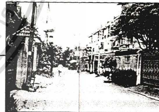
อาคารพักอาศัย 3 ชั้น
