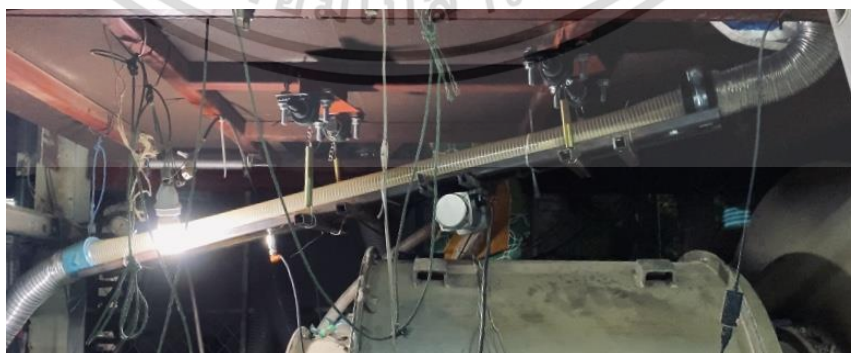
รูปที่ 4.5 การติดตั้งภาตสันสะเทือนปรับปรุงใหม่
