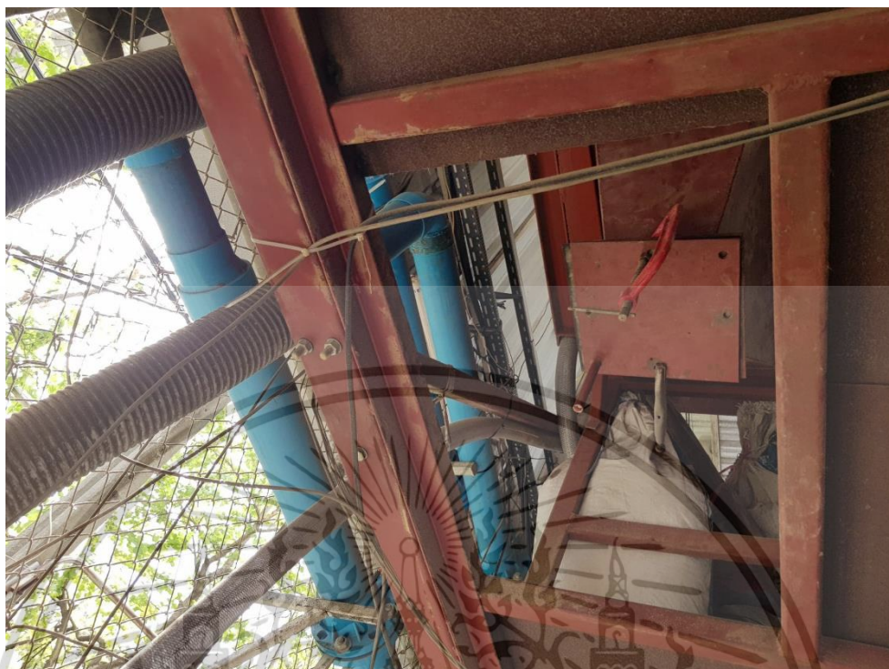
รูปที่ ก.9 พื้นที่ก่อนการติดตั้ง
