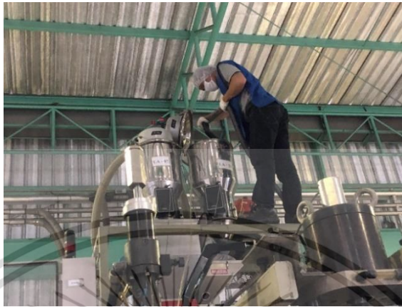
รูปที่ 3.26 พนักงานช่างทำความสะอาดภายในกรวยเติมแต่ละอัน
