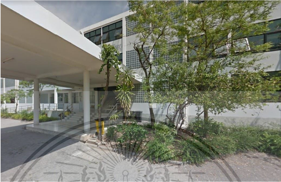
รูปที่ 3.3 อาคารปฏิบัติการรวม CCA โซน C
