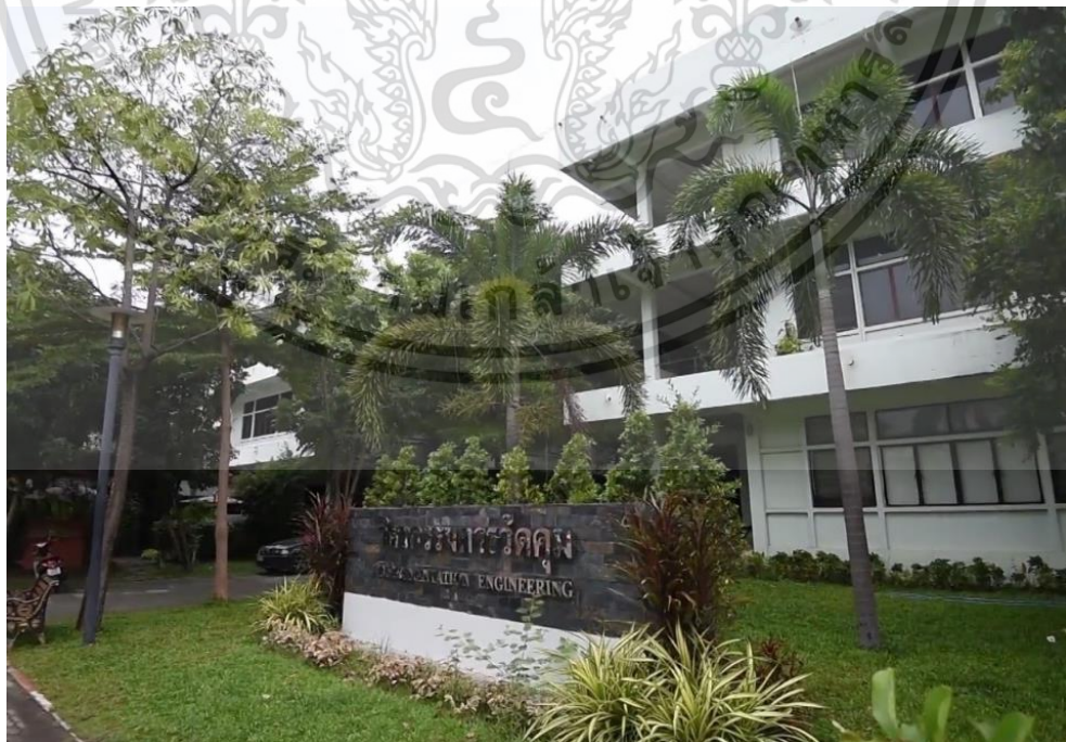
รูปที่ 3.12 อาคารวิศวกรรมการวัดคุม
