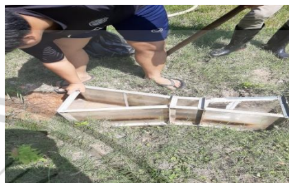
รูป 3.10 ติดตั้ง Parshall Flume
