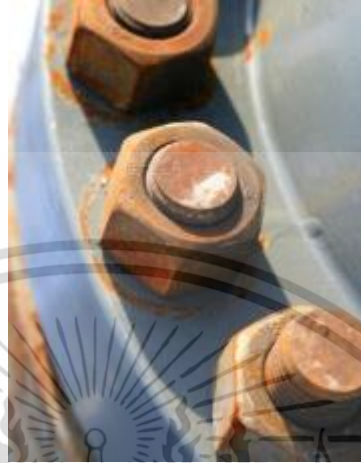
รูปที่ 2.11 ลักษณะการเกิดของการกัดกร่อนเนื่องจากความต่างศักย์
