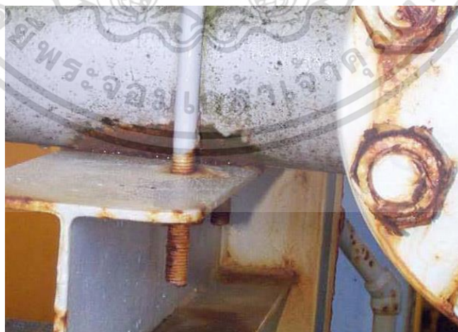
รูปที่ 2.12 ลักษณะการเกิดของการกัดกร่อนแบบช่องแคบ
