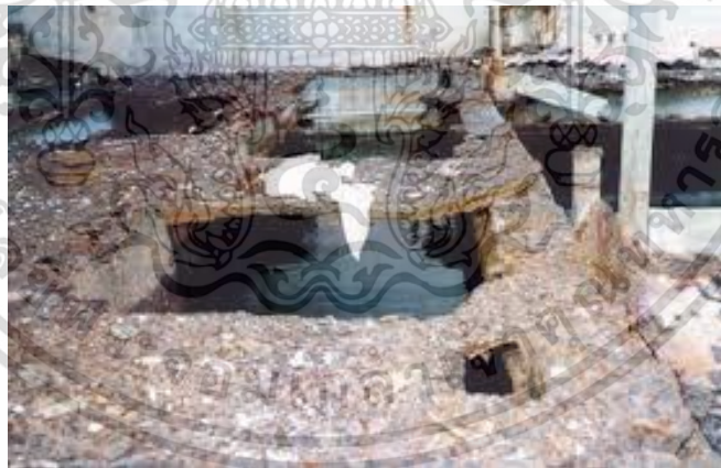
รูปที่ 2.10 ลักษณะการเกิดของการกัดกร่อนแบบสม่ำเสมอ
