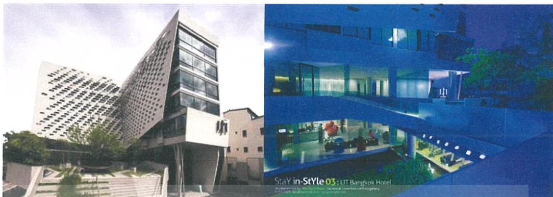
1.6.1.2 รูปภาพแสดงลักษณะภายนอกของอาคาร
