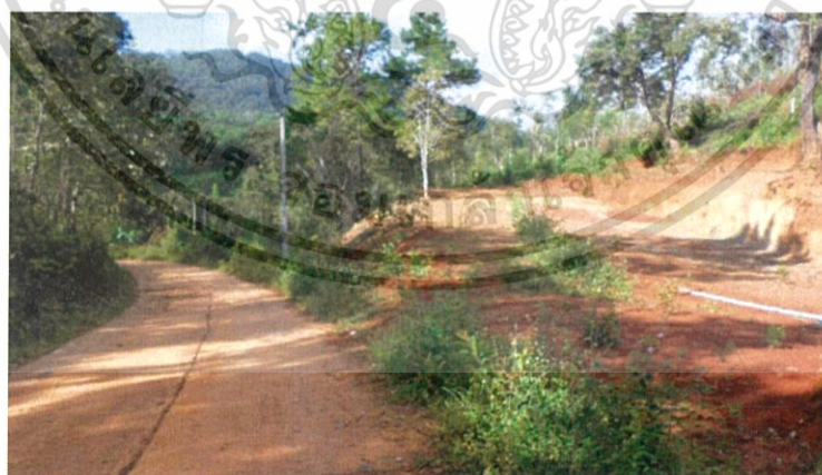
ภาพที่ 4-7 ถนนทางเข้าโครงการ 1
