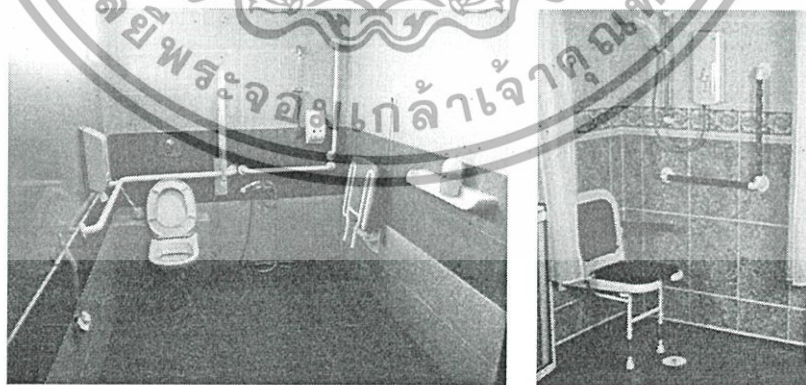
รูปภาพที่49 แสดงตัวอย่างห้องน้ำที่ติดตั้งอุปกรณ์ต่างๆให้อยู่ในระดับที่ผู้พิการสามารถเอื้อมถึงและติดราวเกาะตามผนัง
