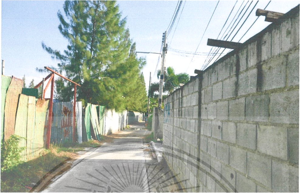
รูปที่ 7.18 สภาพแวดล้อมด้านที่ติดกับชุมชน (ด้านทิศตะวันตก)
