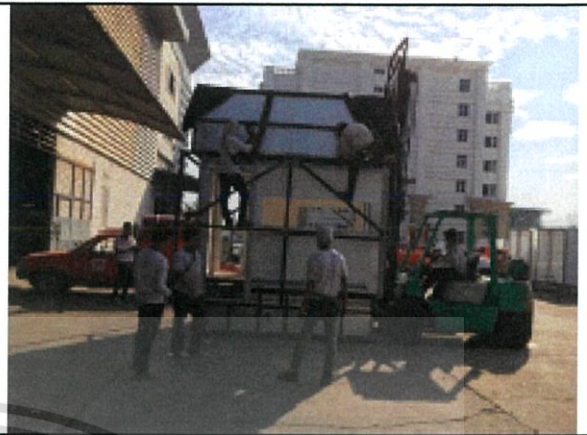
ข. การยกโครงสร้างแท่นกตหลังคาแบบเดิมน้ำไปวางบนทับบนหลังคา
