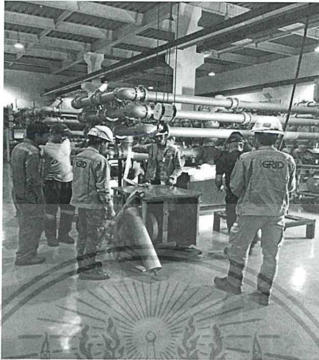
รูป 5.20 ทีมซ่อมบำรุงรักษาทำการเตรียมซ่อมบำรุงชุดกลไกการทำงานของเซอร์กิตเบรกเกอร์
