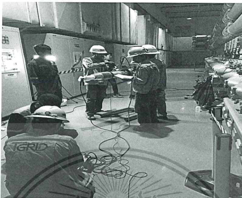
รูป 5.35 ทีมซ่อมบำรุงต่อวงจรทดสอบ Moving Contact ของเซอร์กิตเบรกเกอร์
