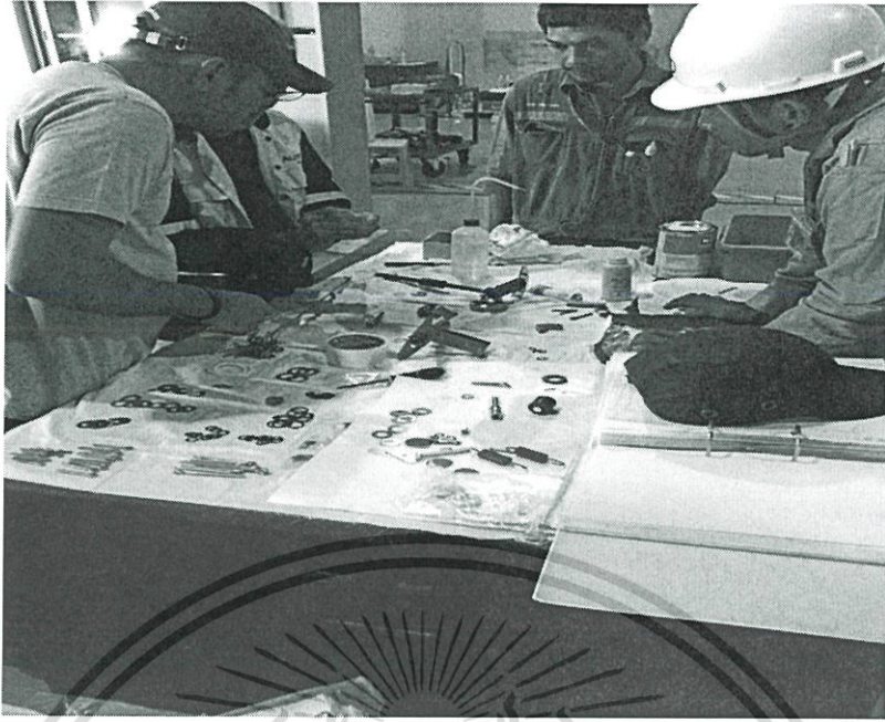
รูป 5.23 Supervisor ทำการวางแผนเปลี่ยนอะไหล่ของชุดกลไกการทำงานของเซอร์กิตเบรกเกอร์
