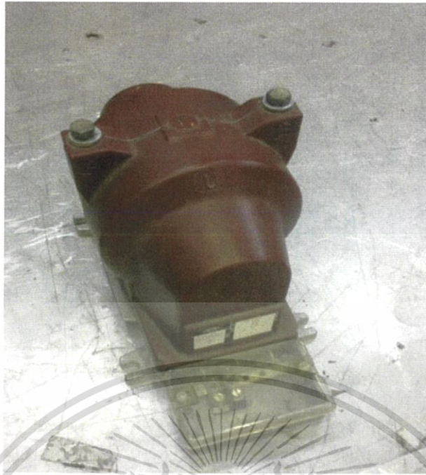
รูปที่ 4.3 หม้อแปลงเครื่องวัดแรงดัน
