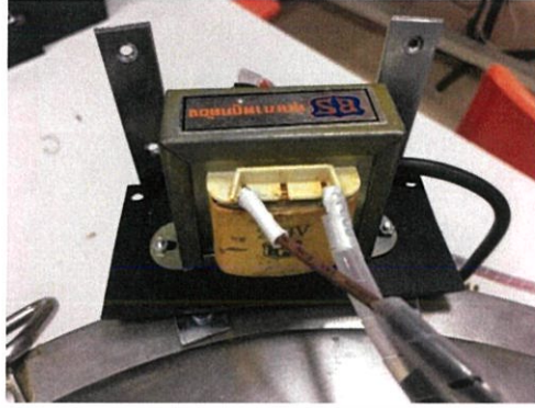
รูปที่ 3.12 การติดตั้งหม้อแปลงไฟฟ้า
