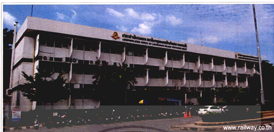
ภาพที่ 2.2 อาคารสำนักงานกลางสถานีบรมจู่และแยกดินค้ำกล่อง ลาดกระบัง ที่มา : การรถไฟแห่งประเทศไทย (2556)
