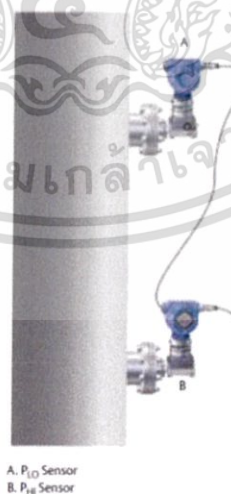
รูปที่ 2.26 ตำแหน่งการติดตั้งอุปกรณ์วัดประเภท Electronic Remote Sensor[22]
