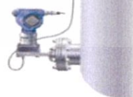
รูปที่ 2.22 ตำแหน่งการติดตั้งอุปกรณ์วัดประเภท Tuned-System[20]
