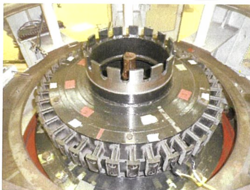
รูปที่ 3.16 โรเตอร์ของเครื่องกำเนิดไฟฟ้าชนิดแม่เหล็กถาวร
