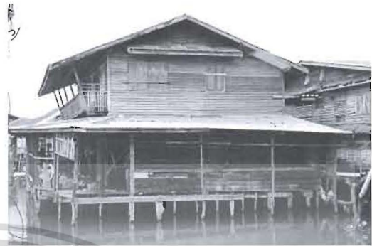
ภาพที่ 3.5 สภาพภายนอกอาคารด้านทิศตะวันออก
