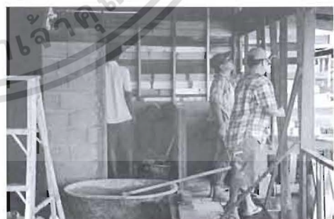
ภาพที่ 3.32 สร้างห้องน้ำ
