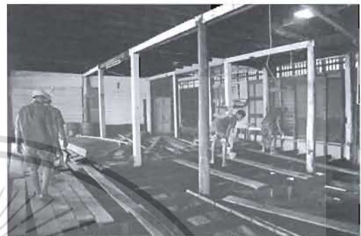
ภาพที่ 3.28 รั้วพื้นไม้ชั้นล่าง ยกพื้นชั้นล่างให้สูงขึ้น และเสริมโครงสร้างพื้นชั้นล่าง
