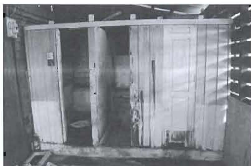
ภาพที่ 3.10 ห้องน้ำชั้นล่าง
