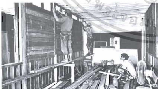
ภาพที่ 3.31 กั้นห้องภายในใหม่ทั้งชั้นล่างและชั้นบน
