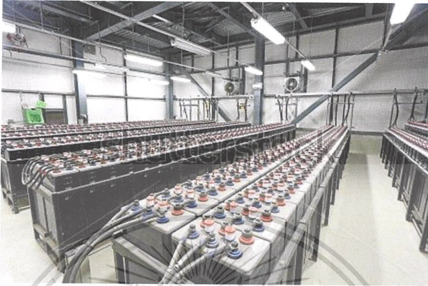
รูปที่ 1.5 ระบบสำรองพลังงานไฟฟ้าในสถานีไฟฟ้าย่อยโดยใช้แบตเตอรี่
