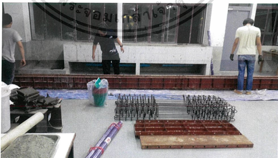
รูปที่ 3.4.1 ประกอบแบบหล่อคอนกรีต
