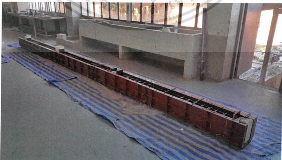
รูปที่ 3.4.3 นำโครงสร้างเหล็กเสริมมาใส่แบบหล่อคอนกรีตพร้อมกันแบบ
