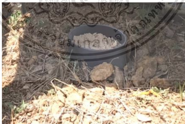
รูปที่ 3.10 ลักษณะการฝังแท่งเหล็กที่บรรจุระเบิด
