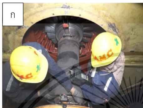
รูปที่ 3.3 ก) การวัดค่า Alignment ก่อนการรื้อถอน และ ข) การปลด busbar
