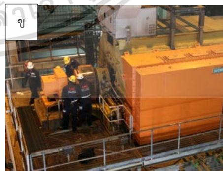
รูปที่ 3.5 ก) ถอด casing D-end และ ข) ND-end
