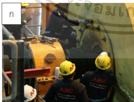
รูปที่ 3.5 ก) ถอด casing D-end และ ข) ND-end
