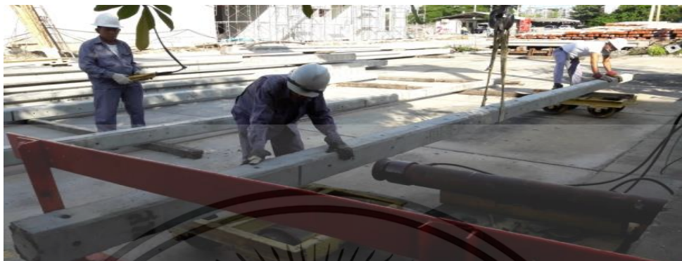
รูปที่ 3.19 แสดงการติดตั้งเสาไฟฟ้าเข้ากับแท่นทดสอบ
