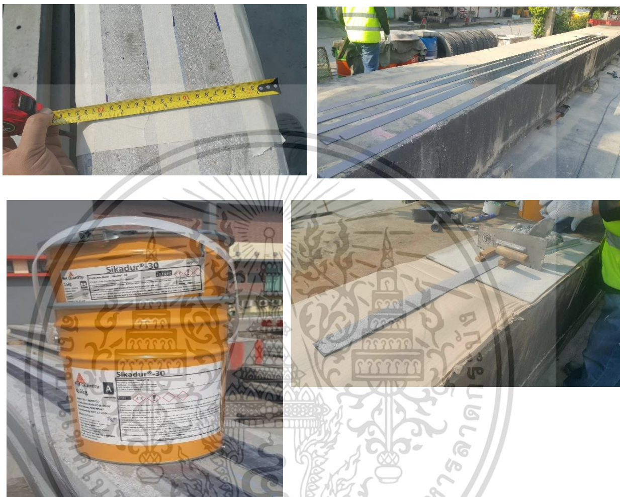
รูปที่ 3.14 แสดงการเตรียมตำแหน่งการติดแผ่น CFRP และเตรียมแผ่น CFRP กาวติดแผ่น CFRP Sikadur-30 และอุปกรณ์ทากาวที่แผ่น CFRP
