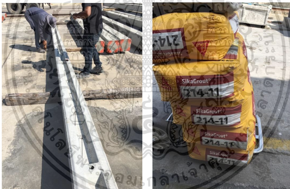
รูปที่ 3.12 แสดงการเตรียมผิวเสาไฟฟ้า และผลิตภัณฑ์ของ Sika 214-11 ที่ใช้อุดร่อง
