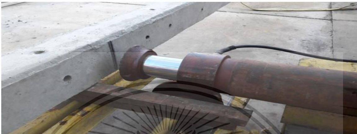
รูปที่ 3.21 แสดงการดันเสาไฟฟ้าด้วยกระบอกไฮดรอลิก
