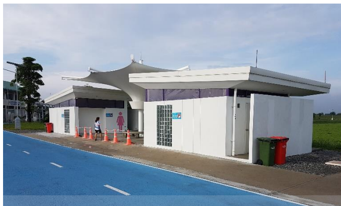
ภาพที่ 2.22 ห้องน้ำจุดพักที่ 3
