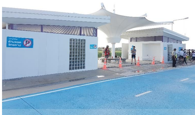
ภาพที่ 2.20 ห้องน้ำจุดพักที่ 2
