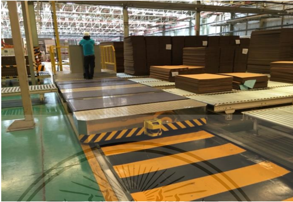
รูปที่ 3.6 การติดตั้งรถขนถ่ายสินค้าคันที่ 2 ในไซต์งาน
