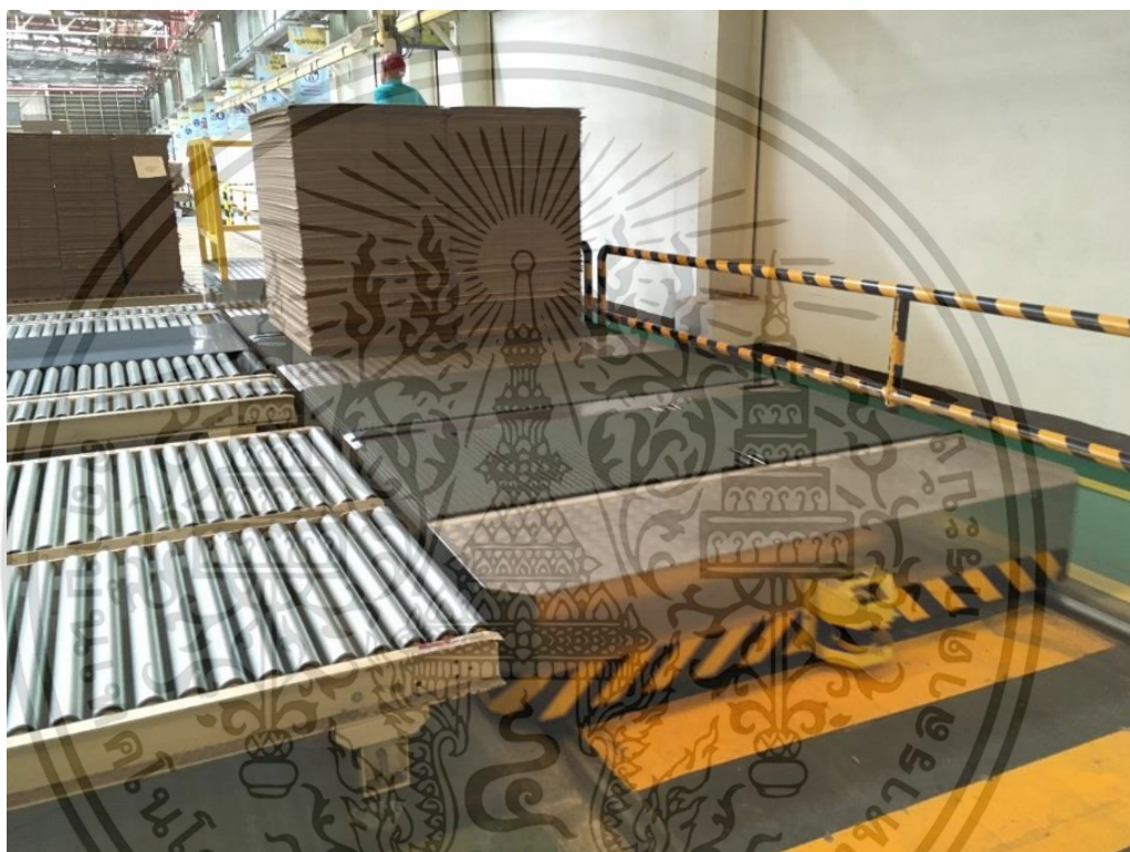
รูปที่ 3.2 การติดตั้งรถขนถ่ายสินค้าคันที่ 1 ในไซต่งาน
