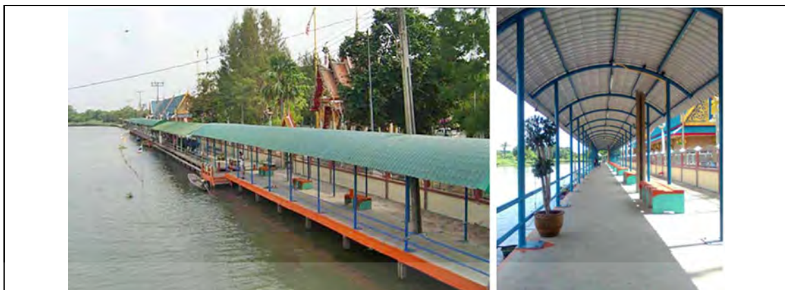
รูปที่ 4.23 แสดงหลังคาคลุมทางเดิน
