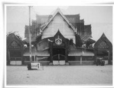
ภาพที่ 2.3 อุโบสถหลังเก่าวัดโสธรวรารามวรวิหาร จังหวัดฉะเชิงเทรา
