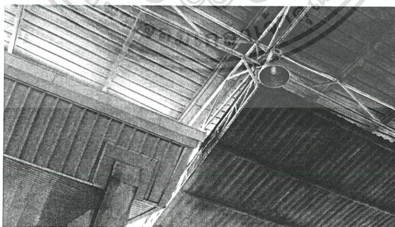
(ภาพที่4.41 โครงสร้างหลังคา และวัสดุ)
