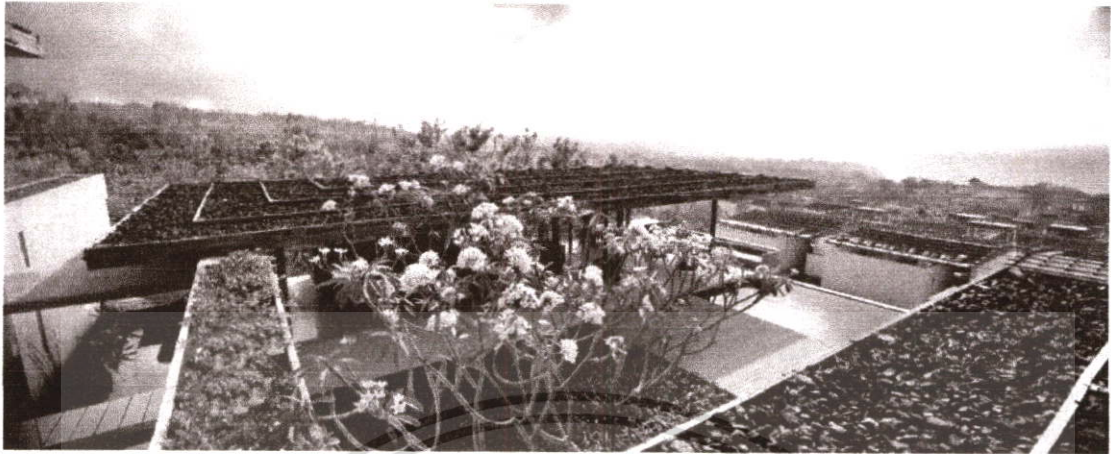
รูปที่3.2 แสดงหลังคาที่ทำจากวัสดุหินภูเขาไฟ
