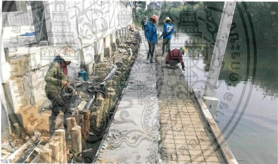
รูป ก4. การซ่อมแซมทางเดินที่เสียหายเนื่องจากการเคลื่อนตัวของดิน
