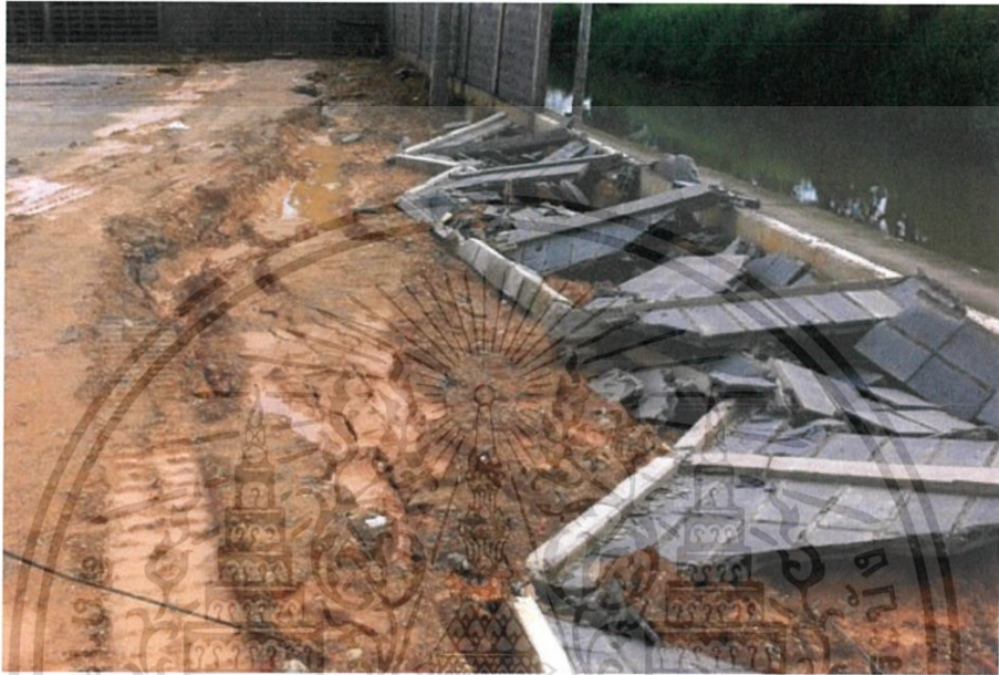
รูป ก1. ลักษณะการวิบัติของดินที่มีการป้องกันดินไม่เพียงพอ
