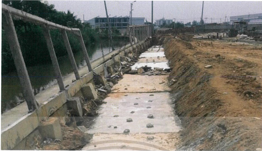
รูป ก3. การแก้ไขการวิบัติของดินแบบ Relieving Platform
