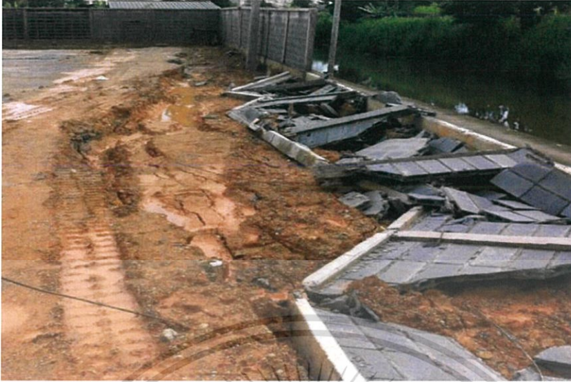
รูป 4.17 สภาพการวิบัติของดินในพื้นที่จริง
