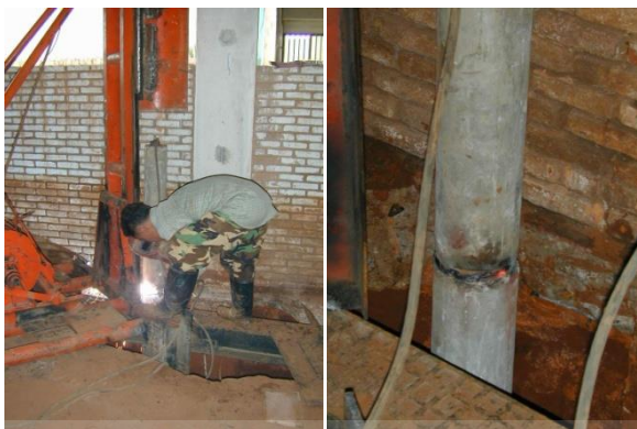
รูปที่ 5.55 แสดงการเชื่อมเสาะเข็มโดยเครื่องเชื่อมไฟฟ้า
