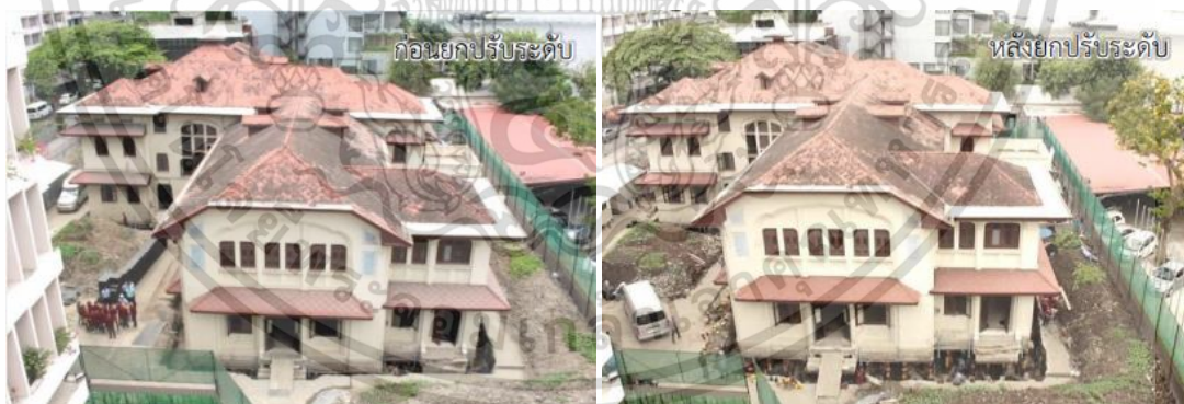
รูปที่ 4.3 แสดงการปรับระดับแก้ไขปัญหาการทรุดเอียงอาคารบ้านมะลิวัลย์ (FAO) กรุงเทพฯ
