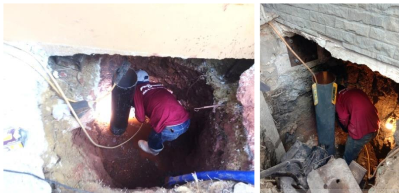
รูปที่ 5.71 แสดงการติดเชื่อมต่อเสาเข็ม ที่มา : บริษัท ฟิเนสส์ ซอยล์ เทสติ้ง จำกัด
