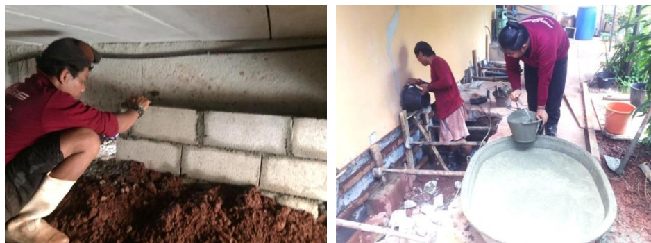
รูปที่ 5.74 แสดงการเข้าแบบหุ้มโครงสร้างถ่ายแรง ที่มา : บริษัท ฟิเนสส์ ซอยล์ เทคโนโลยี จำกัด
