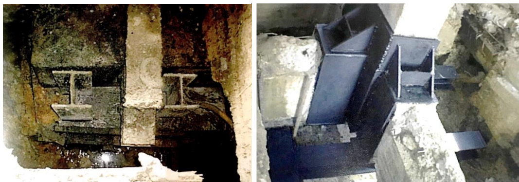
รูปที่ 5.63 แสดงการทำเสาเหล็ก (ซ้าย) และค้ำยันเป็นปาร์รับคานคอดิน (ขวา)
