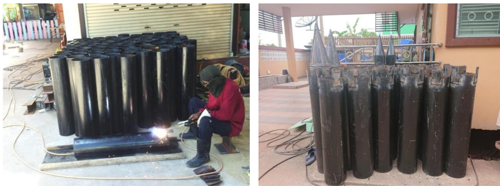
รูปที่ 4.92 แสดงแรงงานฝีมือผลิตเสาเข็มเหล็กรูปพรรณหน้าตัดกลมกลวง (Steel Pile \varnothing ) 20 ซม. ที่มา : บริษัท ฟีนีสส์ ซอยล์ เทสต์ติ้ง จำกัด
