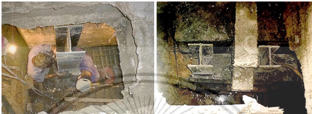
รูปที่ 2.8 แสดงเสาเข็มเหล็กรูปพรรณหน้าตัดตัวเอช (Steel Pile H)
