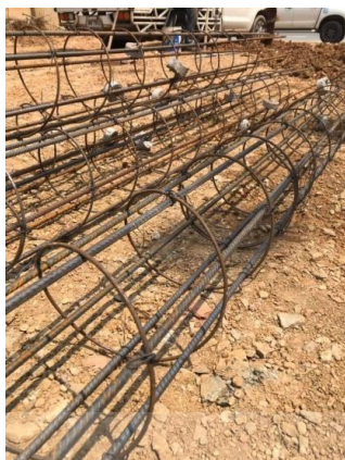
รูปที่ 5.38 แสดงเสาเข็มเจาะและแบบก่อสร้างเข็มเจาะ (Bored Pile)
