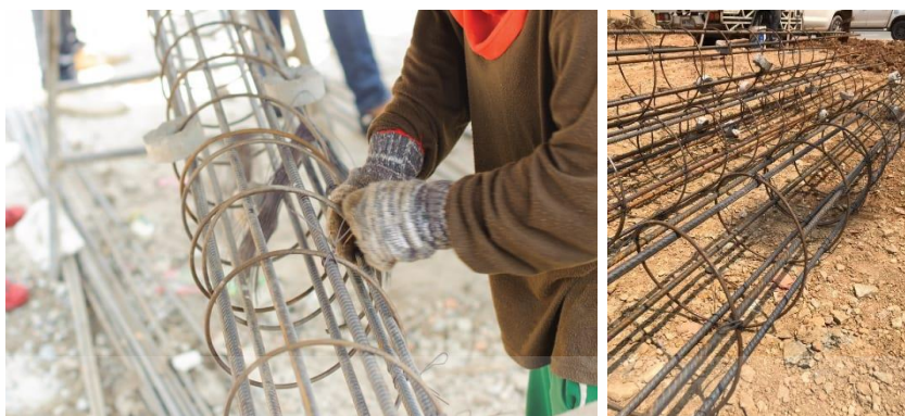
รูปที่ 2.6 แสดงเสาเข็มเหล็ก (Bored Pile)
