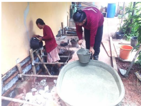
รูปที่ 2.23 แสดงการเข้าแบบและเทคอนกรีต
