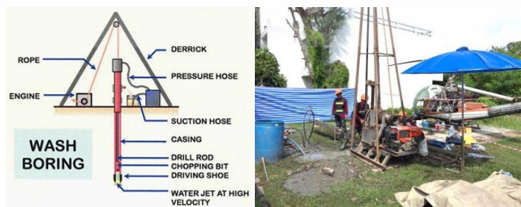
รูปที่ 4.65 แสดงการเจาะสำรวจดินแบบ Wash Boring
