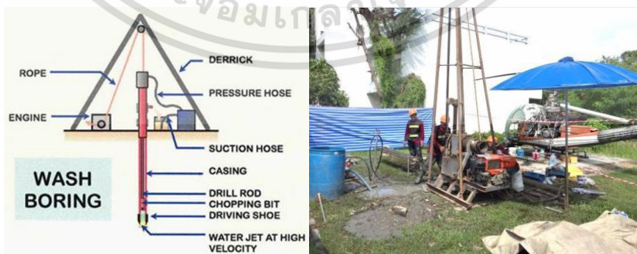
รูปที่ 4.24 แสดงการเจาะสำรวจดินแบบ Wash Boring
