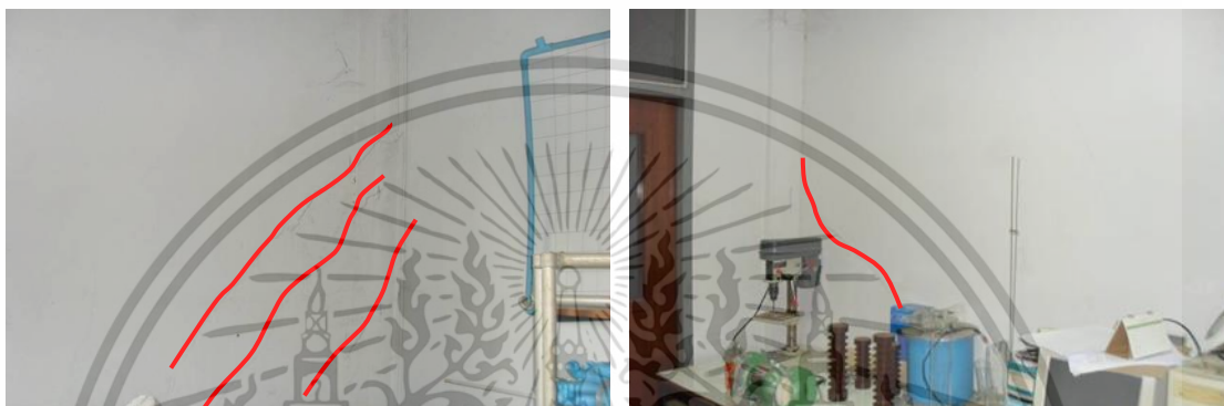
รูปที่ 4.17 แสดงลักษณะรอยร้าวของอาคารกรณีศึกษาที่ 1 ที่มา : บริษัท ฟิเนสส์ ซอยล์ เทสติ้ง จำกัด
