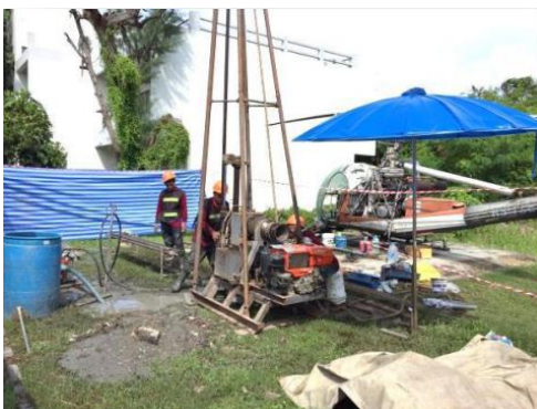
รูปที่ 2.11 แสดงการเจาะสำรวจดินแบบฉีดล้าง Wash Boring
