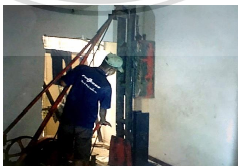
รูปที่ 5.59 แสดงการติดตั้งเสาเข็มรูปพรรณหน้าตัดตัวเอชโดยการใช้ปั้นจั่นขนาดเล็ก
