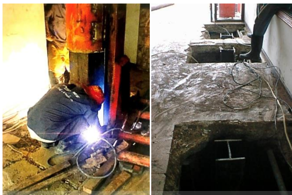
รูปที่ 5.60 แสดงการเชื่อมเสาะเข็มโดยเครื่องเชื่อมไฟฟ้า (ซ้าย) และเสาะเข็มที่ตอกแล้วเสร็จ (ขวา)
