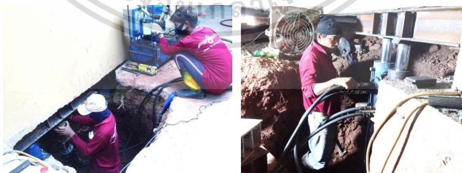
รูปที่ 5.70 แสดงการติดตั้งเสาเข็มด้วยแม่แรงไฮดรอลิก ที่มา : บริษัท ฟิเนสส์ ซอยล์ เทสติ้ง จำกัด
