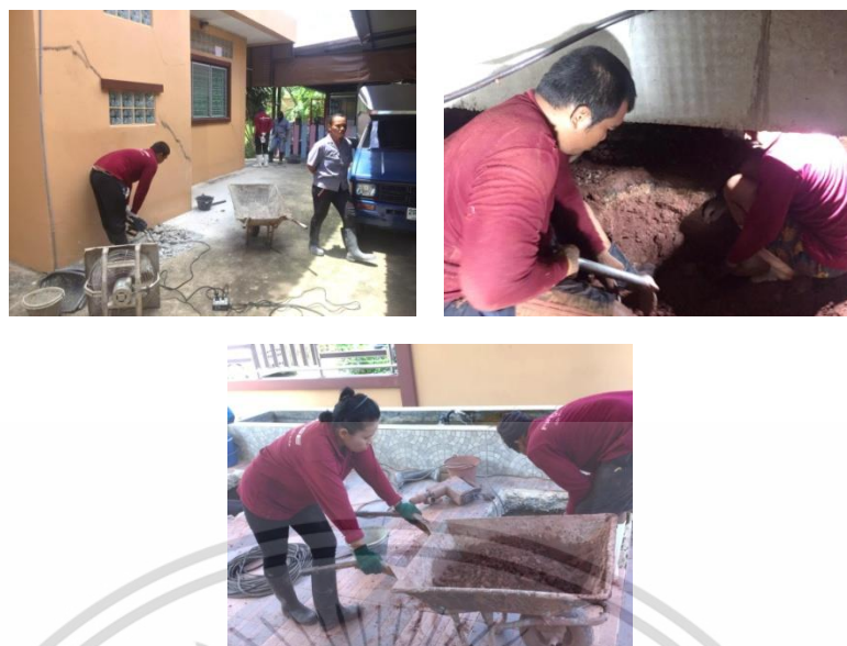
ภาพที่ 5.68 แสดงการสกัดคอนกรีตและขุดเปิดหน้าดินในการซ่อมแซมใช้เสาเข็มเหล็กรูปพรรณ Ø ที่มา : บริษัท ฟิเนสส์ ซอยล์ เทสติ้ง จำกัด
