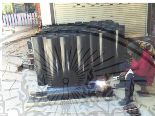
รูปที่ 5.41 แสดงเสาเข็มเหล็กรูปพรรณหน้าตัดกลมกลวง (Steel Pile Ø) ที่มา : บริษัท ฟิเนสส์ ซอยล์ เทส汀 จำกัด และ ผู้ทำการศึกษา
