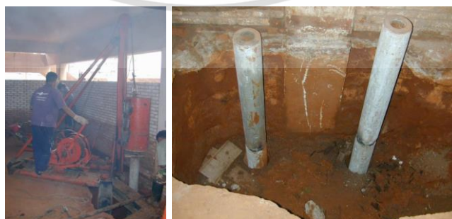
รูปที่ 5.54 แสดงการติดตั้งเสาเข็มประกอบโดยการ ใช้ปั้นจั่นขนาดเล็ก
