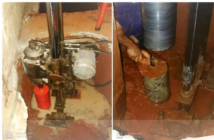
รูปที่ 4.47 แสดงลักษณะการใช้เครื่องเจาะนำทะลุฐานรากเดิมเพื่อติดตั้งเสาเข็มใหม่ ที่มา : บริษัท ฟิเนสส์ ซอยล์ เทสติ้ง จำกัด
