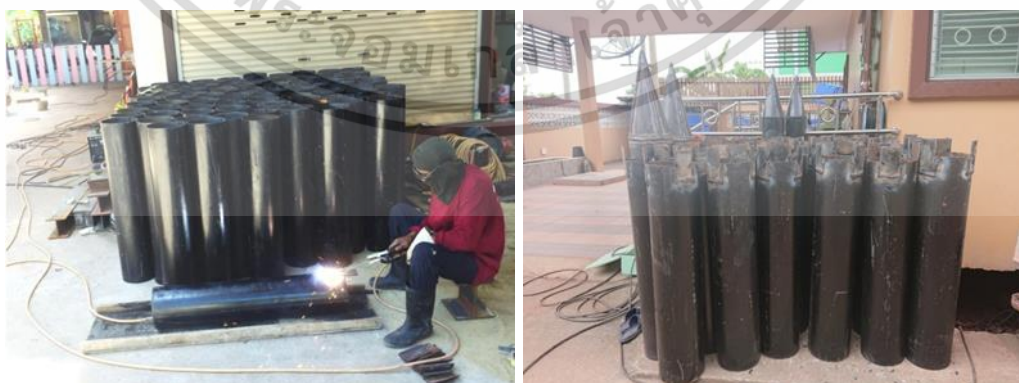
รูปที่ 2.9 แสดงเสาเข็มเหล็กรูปพรรณหน้าตัดกลมกลวง (Steel Pile O)
