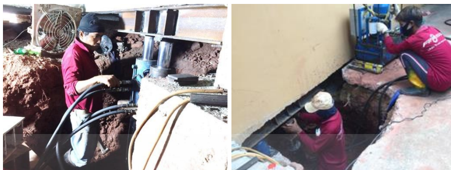
รูปที่ 2.20 แสดงการใช้ไฮดรอลิกในการติดตั้งเสาเข็ม
