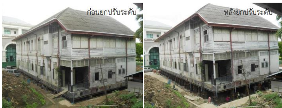
รูปที่ 4.4 แสดงการยกอาคารอนุรักษ์โรงสุรบางยี่ขัน เขตบางพลัด กรุงเทพฯ ที่มา : บริษัท ฟิเนสส์ ซอยล์ เทสติ้ง จำกัด
