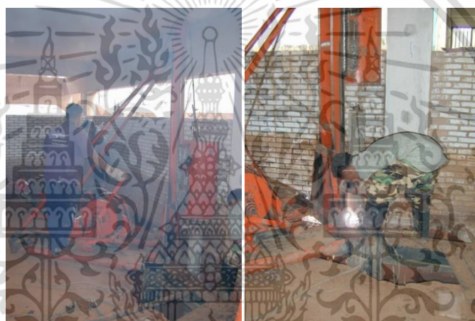
รูปที่ 4.48 แสดงลักษณะการติดตั้งเสาเข็มโดยใช้ปั้นจั่นขนาดเล็กและการเชื่อมเสาเข็มเข้าด้วยกัน ที่มา : บริษัท ฟิเนสส์ ซอยล์ เทสติ้ง จำกัด
