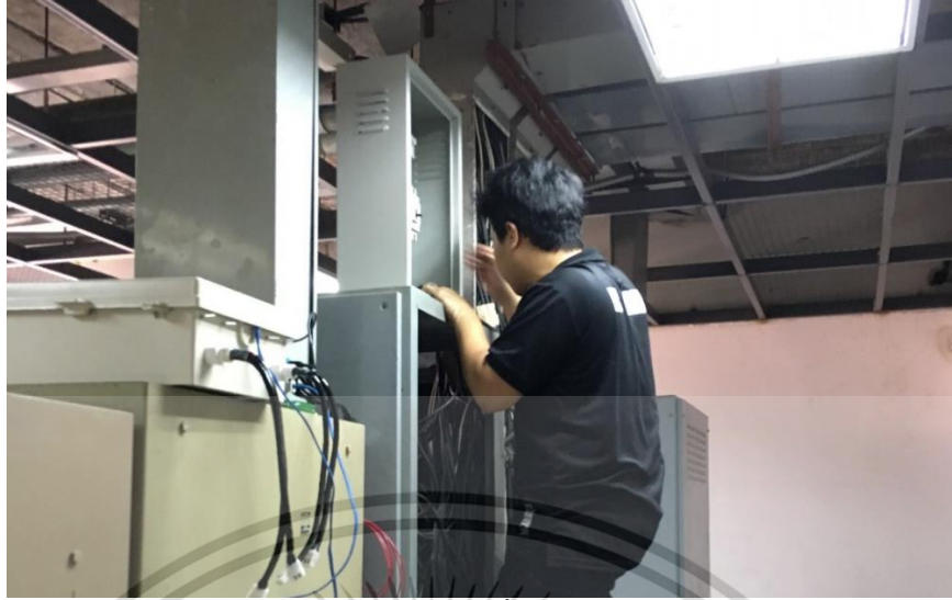
รูปที่ 3.38 การติดตั้งกล่อง Safety
