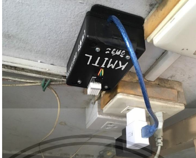
รูปที่ 3.44 ติดตั้งวงจรวัดอุณหภูมิและความชื้น
