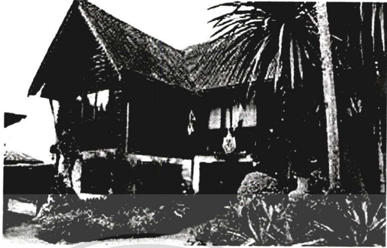
ภาพที่ 3. 3 อาคารอเนกประสงค์
