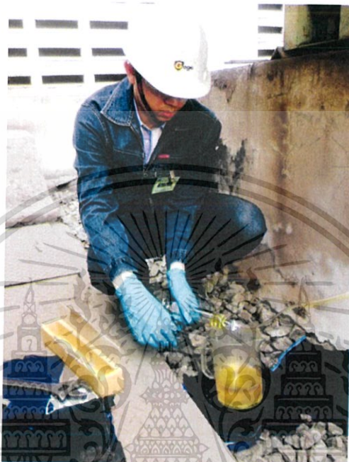
รูปที่ 3.7 การเก็บตัวอย่างน้ำมันหม้อแปลง
