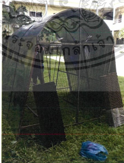
รูปที่ 3.7 ปะเหล็กแผ่น (Metal Sheet) กับโครงโรงเรือน
