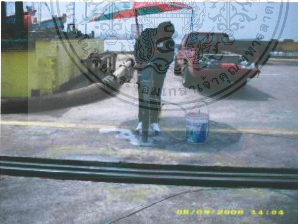
รูปที่ ผก.4 การเก็บตัวอย่างพื้นคอนกรีตโดยวิธีเจาะ
