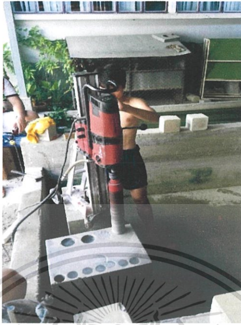
รูปที่ 3.11 กำหนดตำแหน่งที่จะเจาะบนแท่งคอนกรีต
