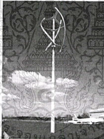
รูปที่ 2.18 กังหันลมแกนหมุนแนวตั้ง
