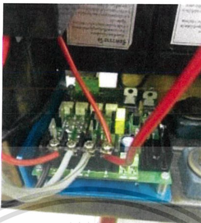
รูปที่ 3.19 แสดงการติดตั้งบอร์ดขับเคลื่อนมอเตอร์
