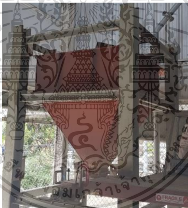
รูปที่ 5.6 ถังเก็บเชื้อเพลิงอัดเม็ดและสกรูขนถ่าย (Silo and screw feed wood pellet)
