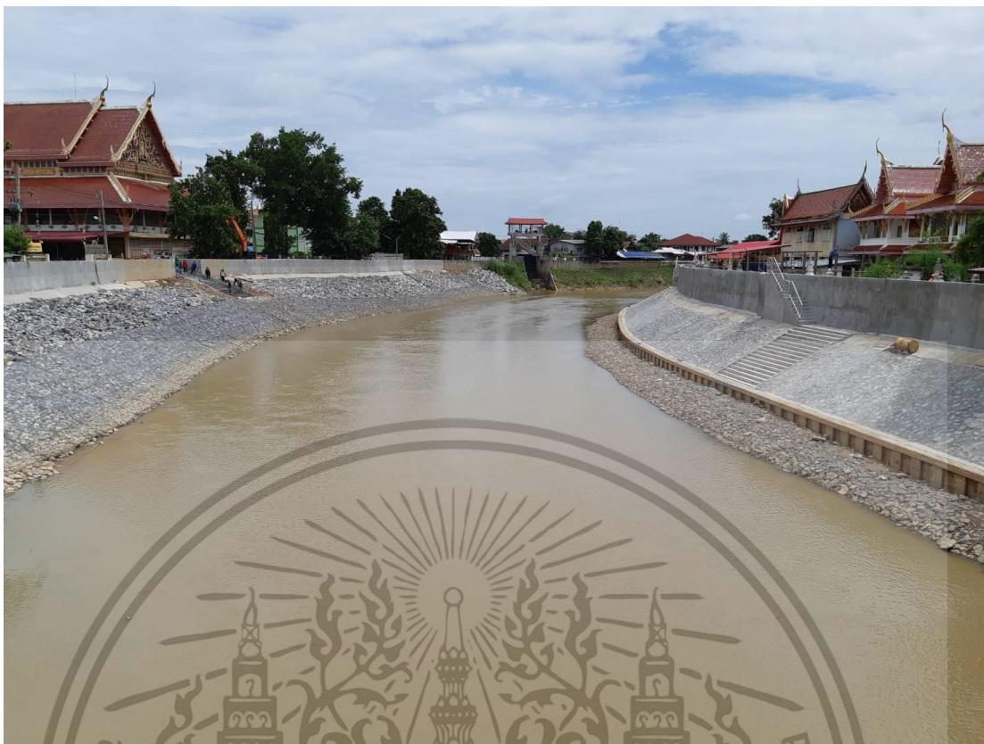
รูปที่ 3.7 คันป้องกันน้ำท่วมบริเวณสะพานพระร่วง ในเขตเทศบาลเมืองสุโขทัยธานี
