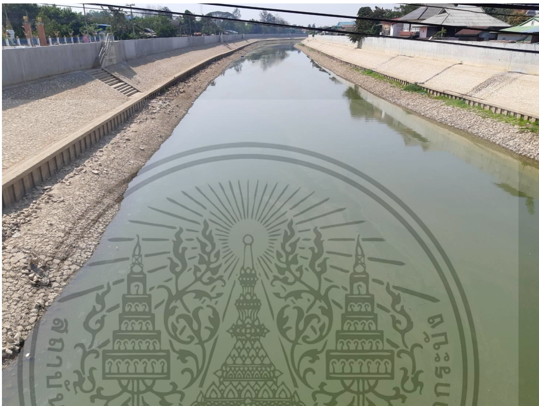
รูปที่ 5.1 รูปแบบการก่อสร้างคันป้องกันน้ำท่วมของกรมโยธาธิการและผังเมือง
