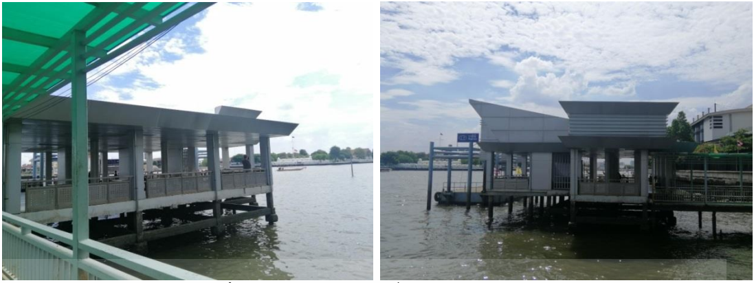
ภาพที่ 4.34 แสดงลักษณะทั่วไปอาคารท่าเรือราชินี ที่มา : ผู้วิจัย
