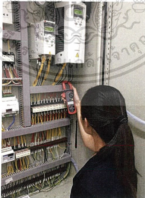
รูปที่ 3.19 วิธีการวัดกระแสไฟฟ้าด้วย Clamp Meter
